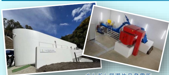
ぐんぎん尾瀬片品発電所
