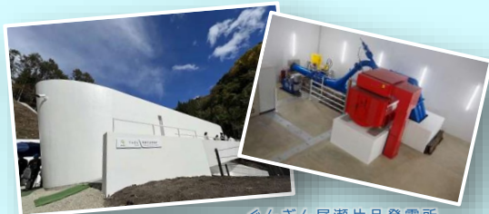
ぐんぎん尾瀬片品発電所
