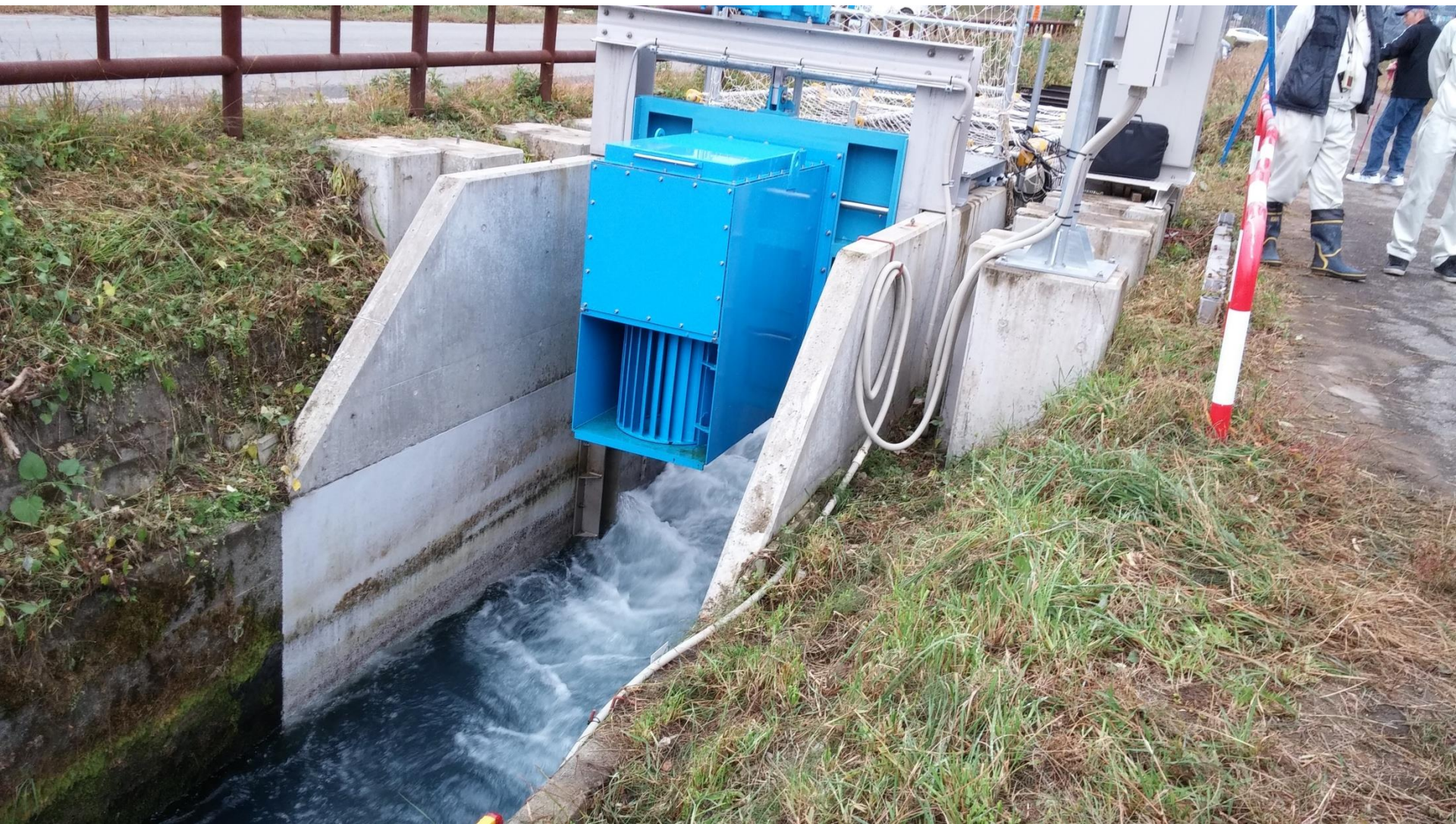
現地設置状況
