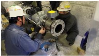
流量計の取り付け
