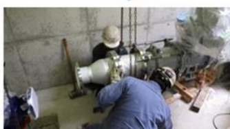
電動弁の取り付け
