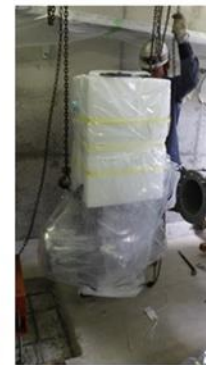
発電機取り付け
