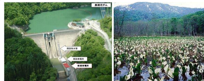
奥裾花第2発電所（水芭蕉発電所）（長野市） （出力980kW 約1,400世帯分を発電）
