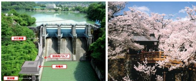
高遠発電所（高遠さくら発電所）（伊那市） （出力180kW 約350世帯分を発電）
