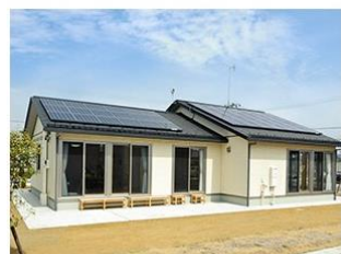
集会所 (防災拠点) ソーラー付 (PV9.1kW)
