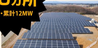
桜岡第三発電所 (396kW)
