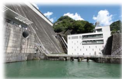
多摩川第一発電所
