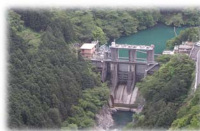
白丸調整池ダム
