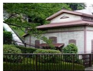
三居沢発電所 仙台市 1888年(明治21年)
