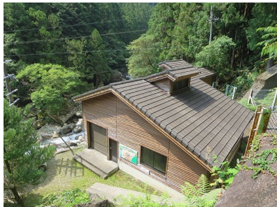
▲新宮市 高田発電所
